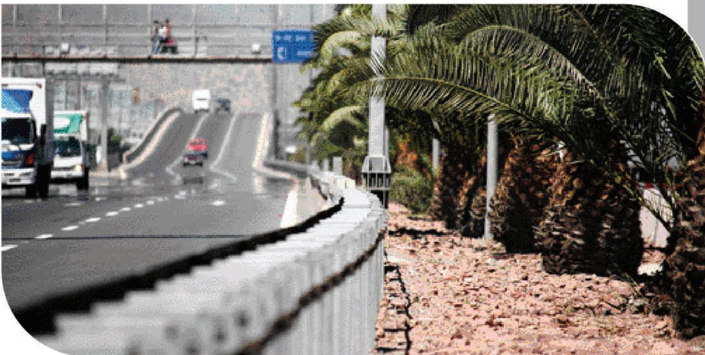
Sector Lo Boza, Tramo 4, Comuna de Renca.
